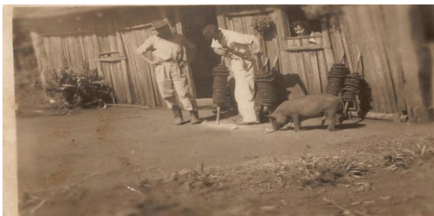
Casa de Fumo, Proprietário Sr. Euzenio Rocco, 1942, hoje é a máquina de arroz do Ico Pires. Atual Avenida Tibagi. (Foto cedida por Luzia Bertassoli)
