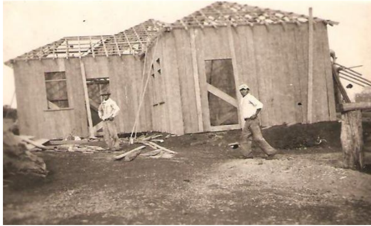
Construção de uma casa na década de 1940, atual Bairro secção Cedro (foto cedida pela família Kishino)
